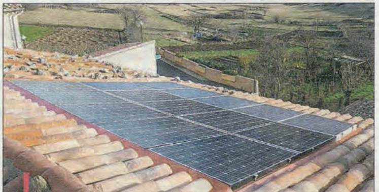
Le panneau solaire "Dualsun" de Solaire 2G produit électricité et eau chaude. Il peut être installé sur le toit d'une maison ou d'un immeuble.
